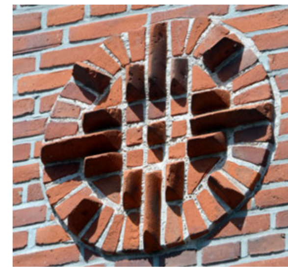
Mit Liebe zum Detail wurden die Ornamente der Backstein-Fassaden saniert.
