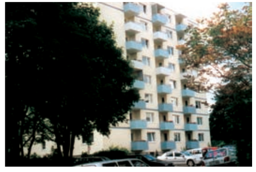
Das Hochhaus im Moorkamp 1 in Kiel wurde 1965 gebaut. Im Jahr 2000 haben wir die Außenfassade wärmege-dämmt und verschönert, das Treppenhaus renoviert und die Außenanlagen zeitge-mäß gestaltet.
