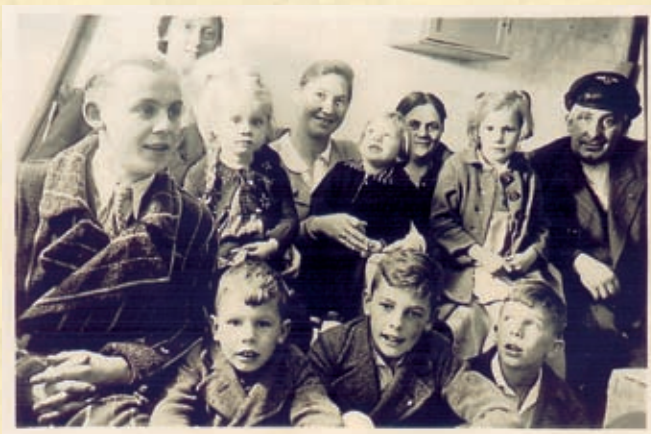
Ausharren im Luftschutzbunker. Diese Aufnahme wurde im Uhlenkrog gemacht.
